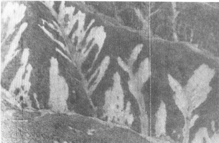
写真II-3 喬木・大鹿境付近の崩壊の跡
