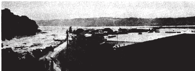
新宮川の氾濫で埋まった新宮川岸（新宮川橋流失）
