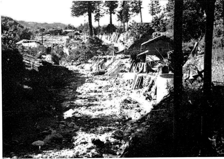
上 建物の土台を大谷沢に洗わる（北組）
