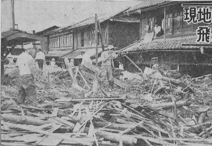
野底川の鉄砲水が運んだ流木と家屋の残骸 (飯田中央商店街)
