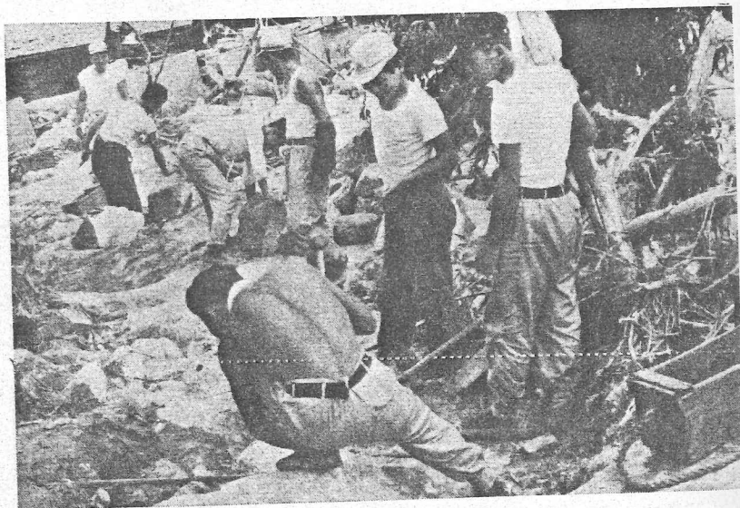
石工科の飯田市今宮における作業現場
