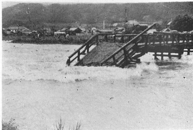
流れてしまった辰野町昭和橋 一諏訪湖から流れ出る天流川は警戒水位を突破し、 各地で橋を流失し、堤防を欠壊してあばれまわった一
