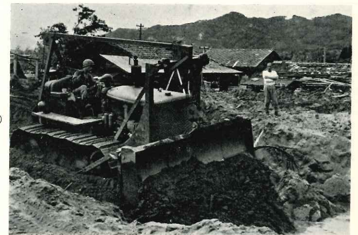
懸命な排土作業(松川中学校基地)
