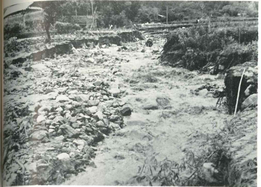
米川 飯田市米川 工事費 81,137千円 流路工 2,310m 法 長 2.9~3.2m 落差工 49基 帯 工 102基
