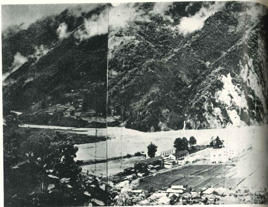
下伊那郡大鹿村大河原被災状況
