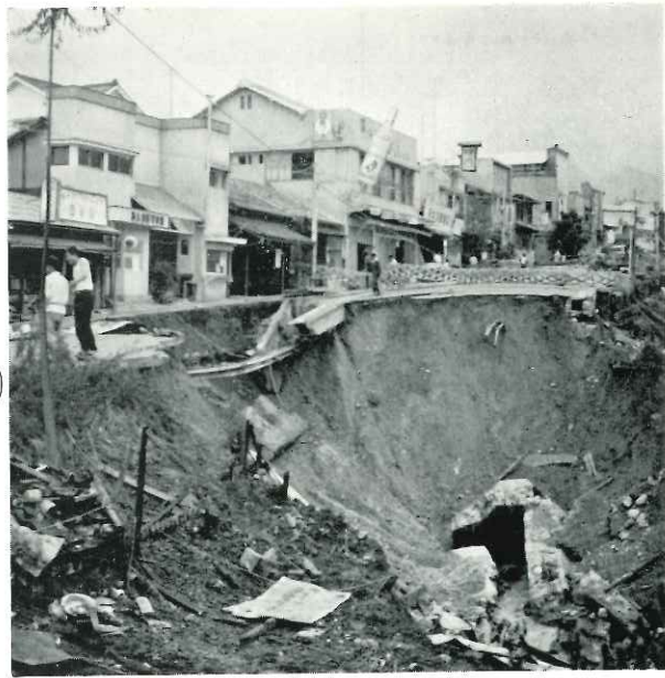
道路にあいた大穴 (2級国道飯田豊橋線) 飯田市長姫町
