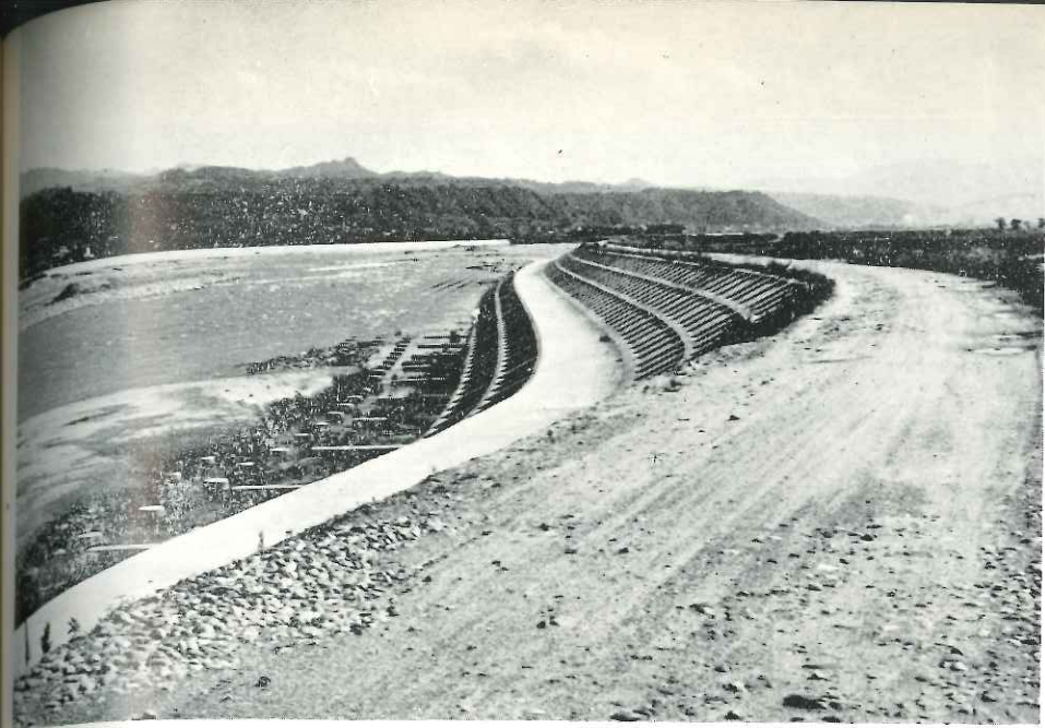
天竜川右岸 下伊那郡高森町下市田 築堤工 長 630m 決定工費 123,619千円
