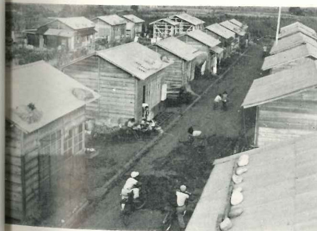
立ちならんだ応急仮設住宅 (駒ヶ根市)
