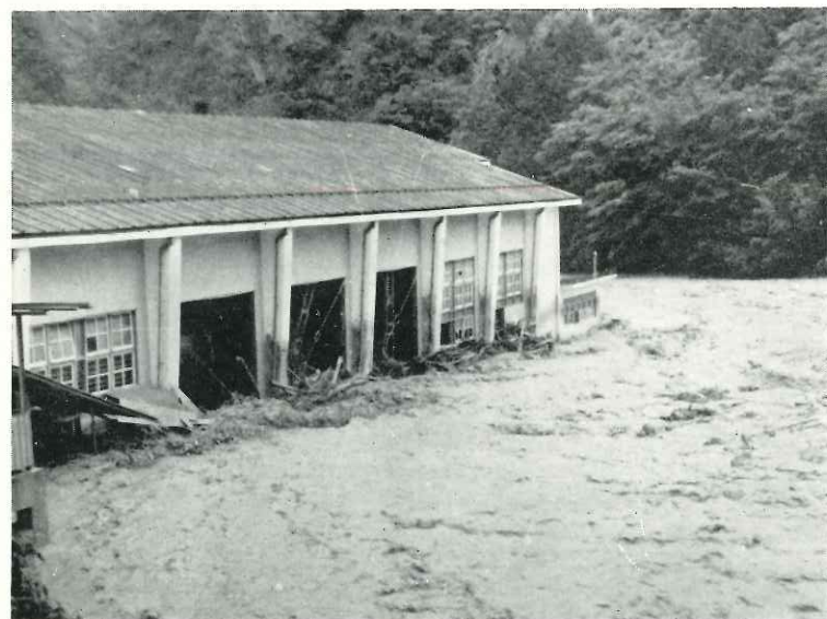
濁流に埋まる体育館（大鹿村鹿塩）
