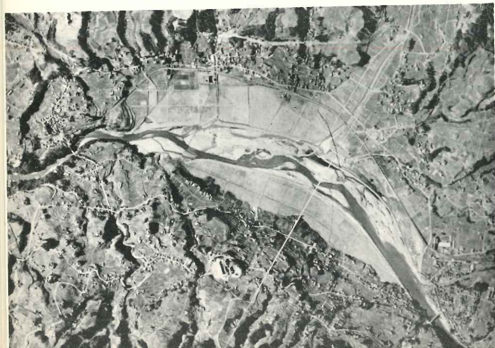
復旧なった同地区
