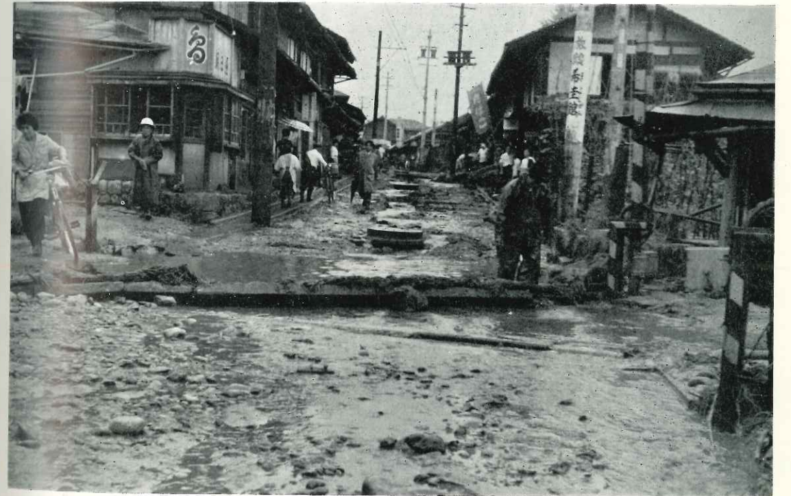
濁流に洗われた道路（県道幸助飯田線飯田市白山町）
