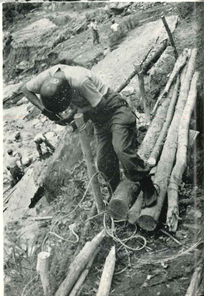
陸上自衛隊田部隊による道路応急工事 (駒ヶ根市四徳線地籍)
