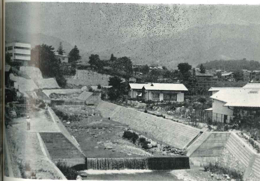
復旧なった同地区
