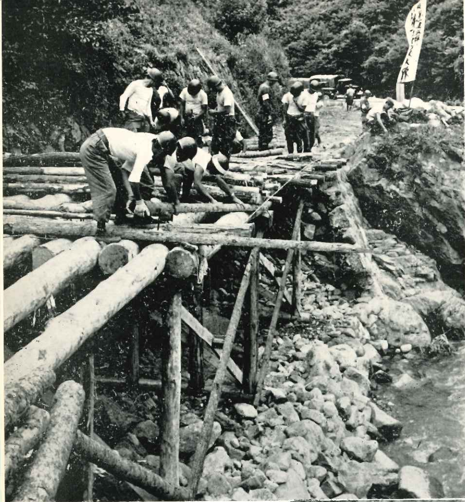
陸上自衛隊の道路応急工事 (新宮川上流駒ヶ根地籍)
