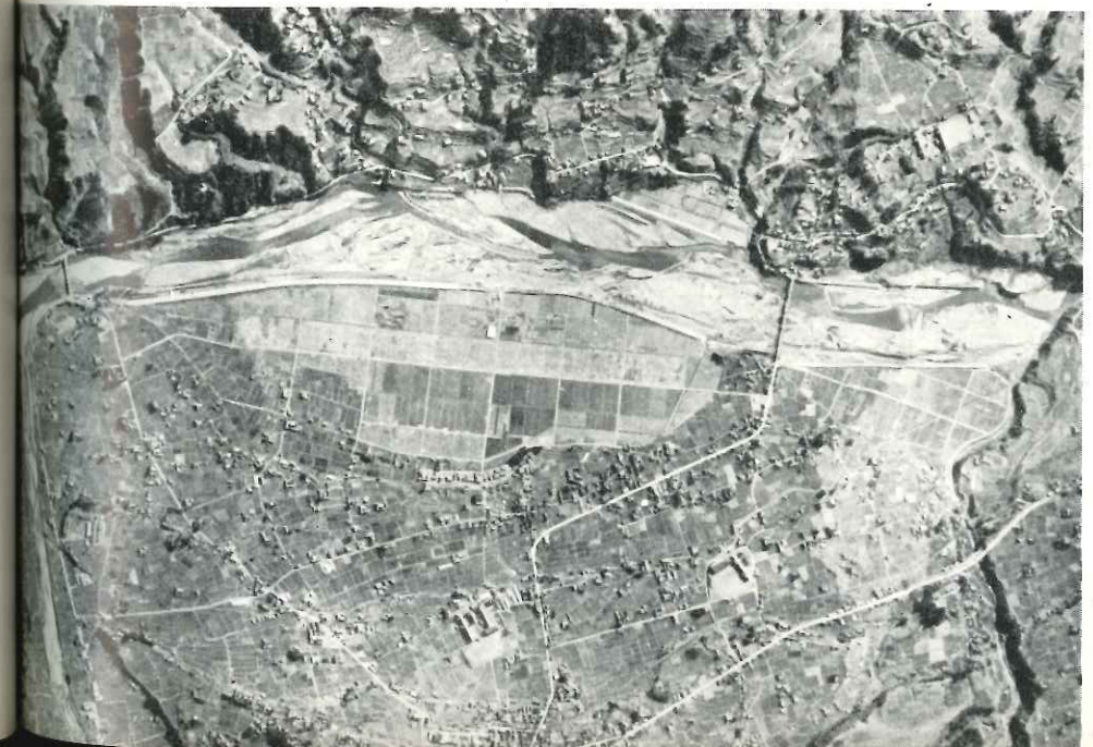
復旧なった同地区
