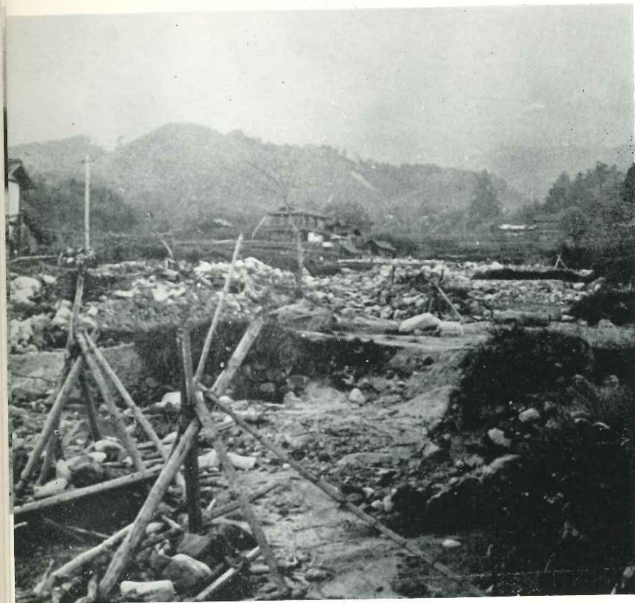
天竜川支久米川小支茂都計川 飯田市下中村
