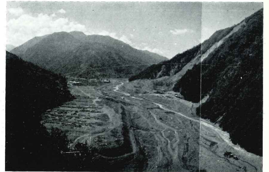
堀削ほぼ終了状況
