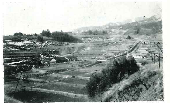
田沢川駒場附近しゅん功写真
