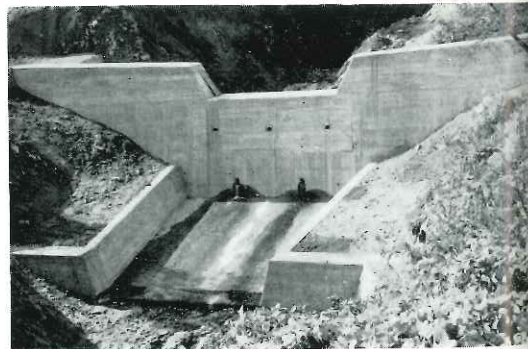
小田沢川砂防堰堤しゅん功写真
