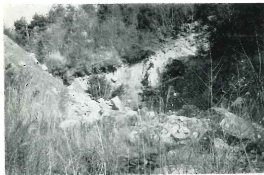
小田沢川水源附近崩壊状況写真
