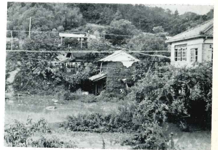
天竜川 川路地区の湛水による被害
