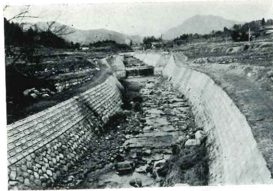
茂都計川現況
