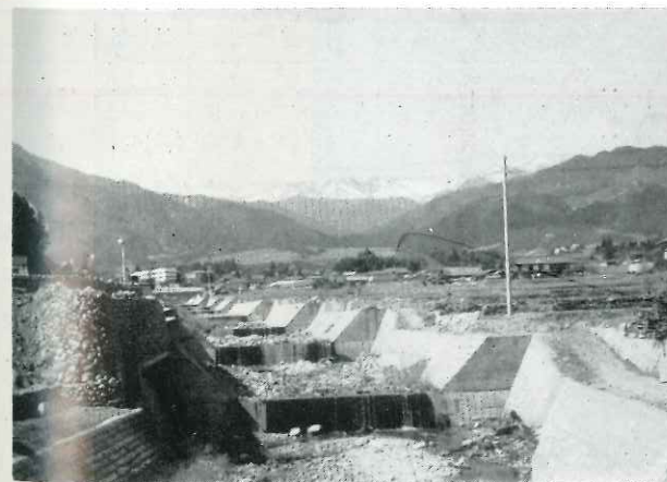
野底川流路工しゅん功写真 (別府)
