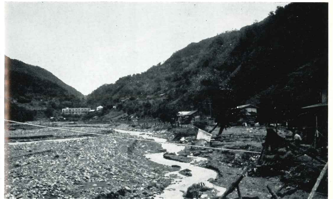
鹿塩川被災状況 (鹿塩橋より占流を見る)
