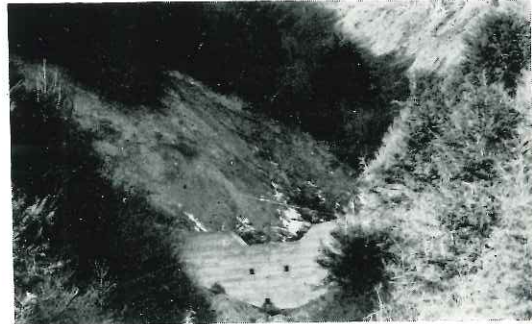
上流谷止工及び崩壊地の状況
