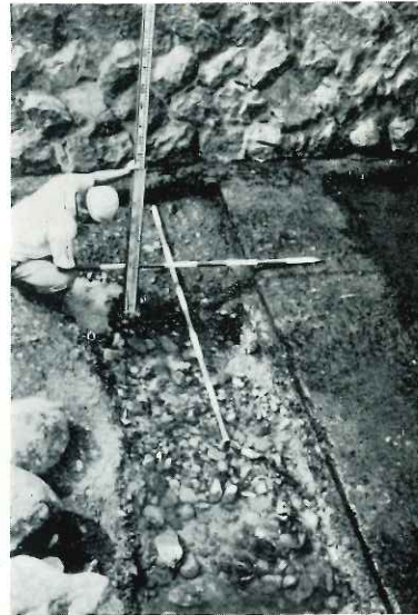
底張工洗掘状況
