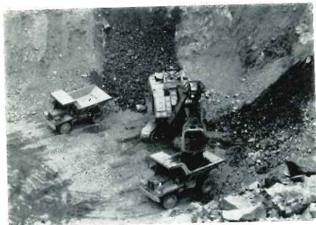
2.3m³ショベルによる堀削
