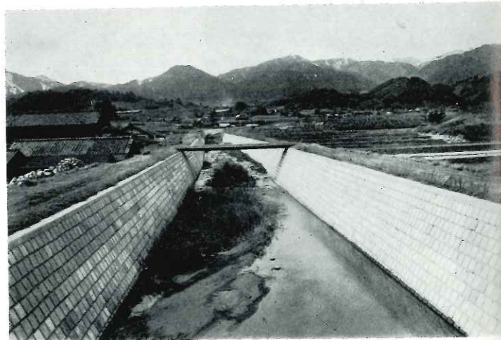
積ブロックによる護岸工 (南大島川)
