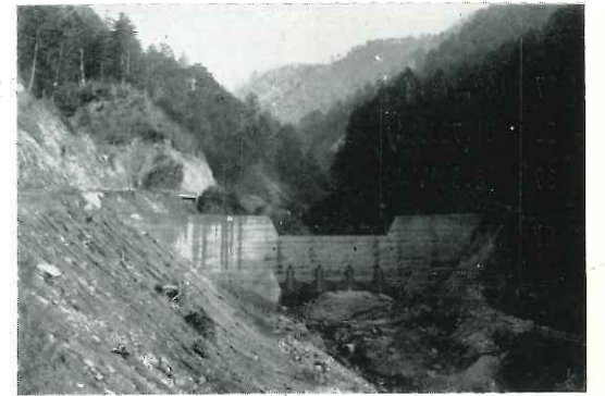
野底川砂防堰堤しゅん功写真 (鈴ヶ沢)
