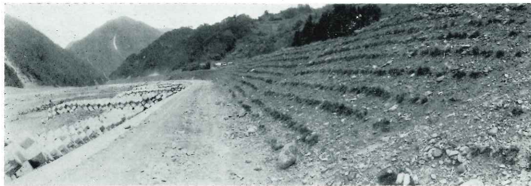
植生盤による土羽工
