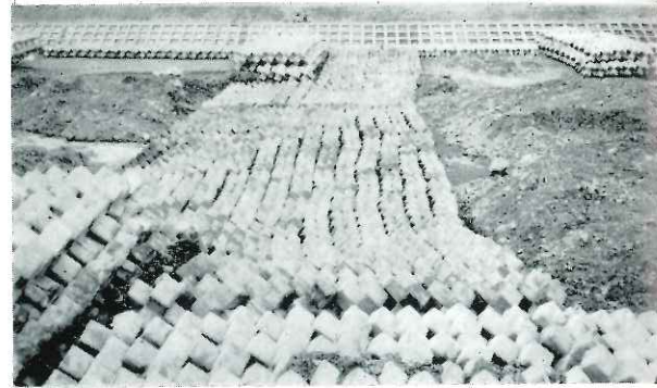
六角ブロックによる床固工
