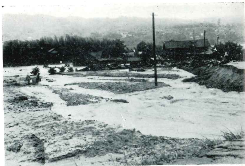
久米川・天竜川 合流点附近被災状況
