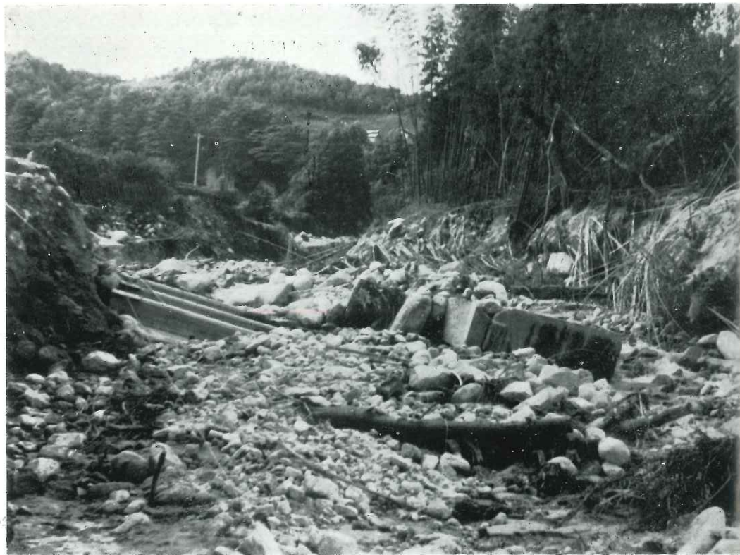
黒田橋附近被災状況
