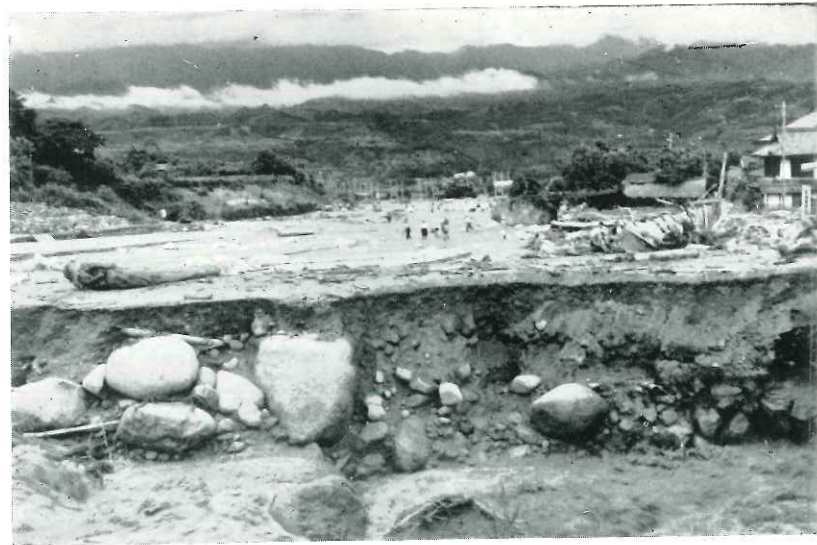
城東地区被災状況 (区画整理地区)
