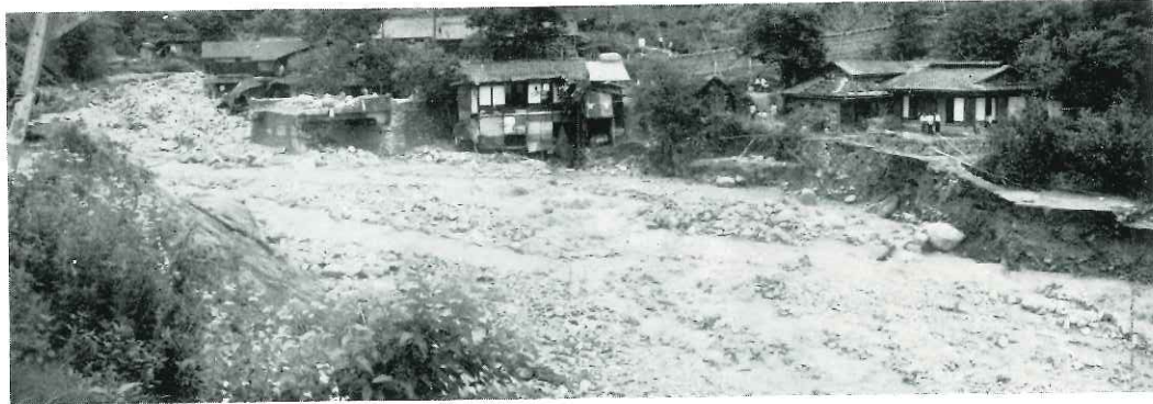
田沢川追分橋附近被災状況写真
