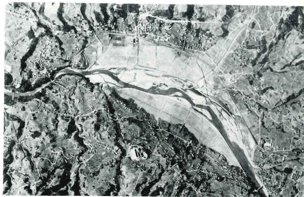
天竜川川路地区しゅん功写真
