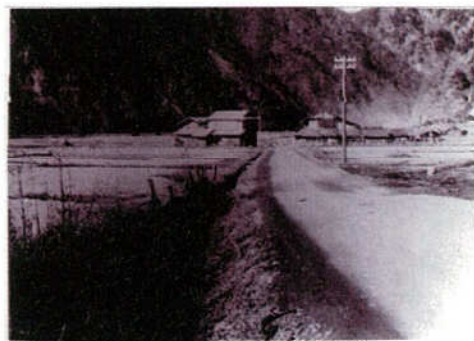
文満地区の国道152号。 田んぼは道路面より低かった
