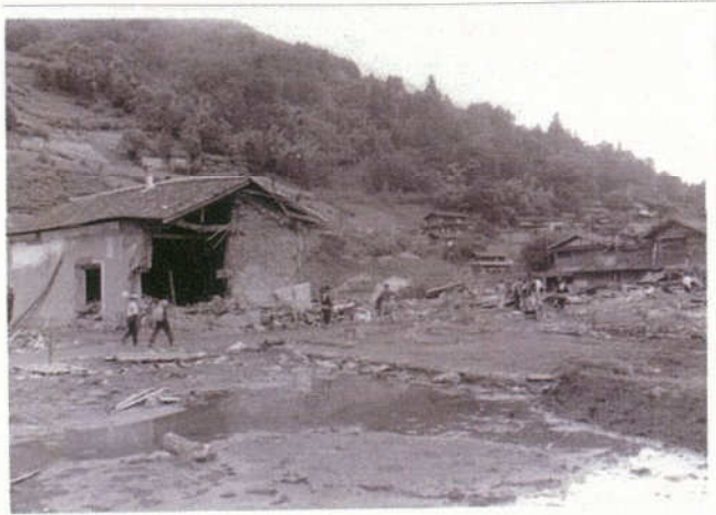
何とか流されなかった農協の倉庫も激しく破壊されている
