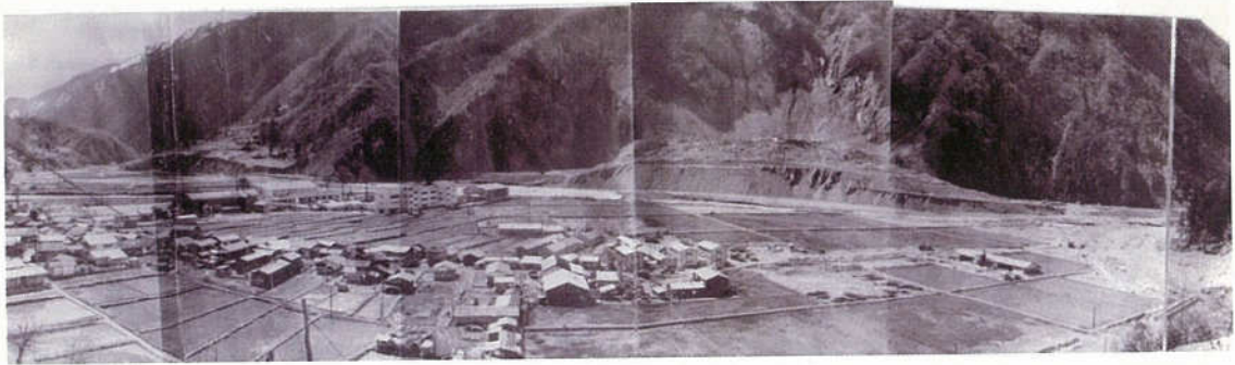
崩壊土砂の一部を取り除き、川をある程度戻し、田んぼの造成が行われている
