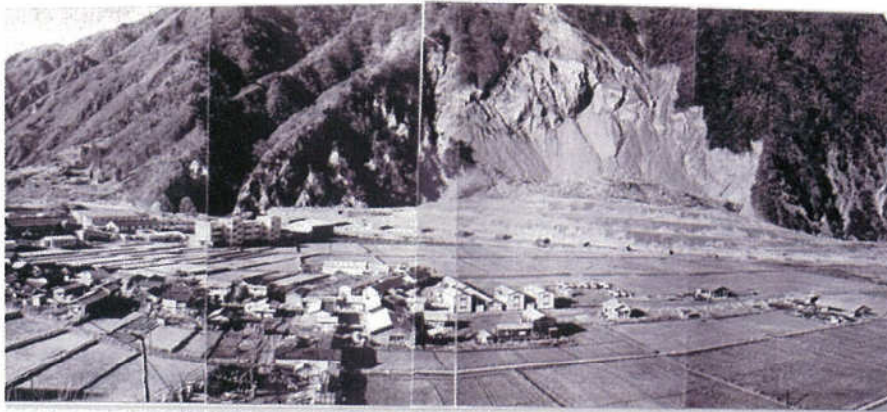
川の形ができ、田んぼも整然とできた当時は工事関係者が約1,000人いた
