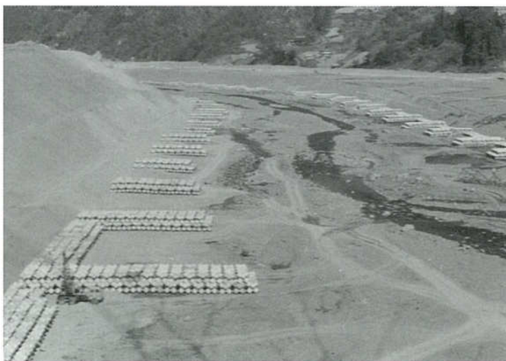
左右両岸に水制が施工され、川も落ち着いた様相を見せ始めた
