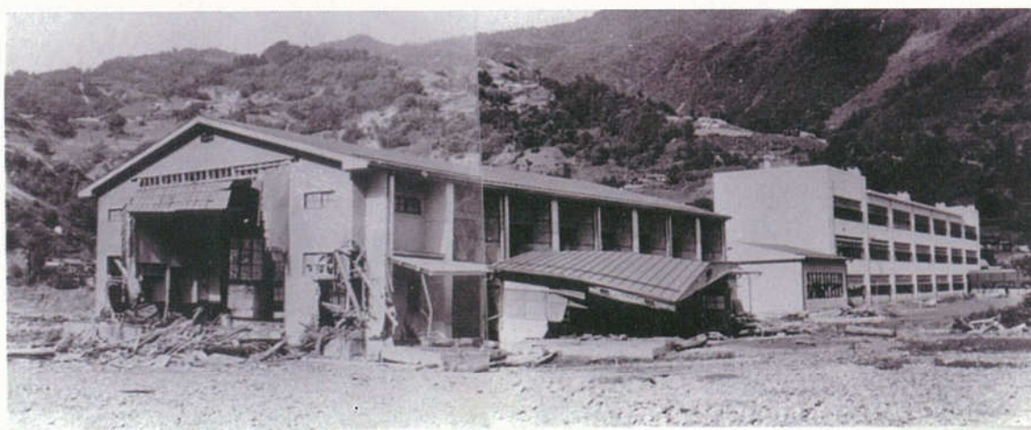
小学校の体育館。土砂崩壊の爆風で穴が開いた
